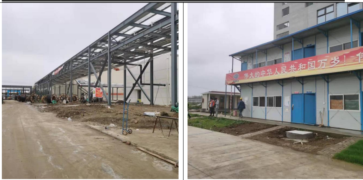
图 2.2-2 永临结合施工道路
