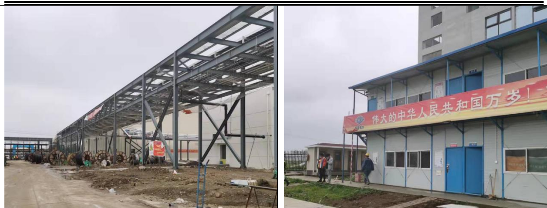
图 2.1-3 工程建设现状
